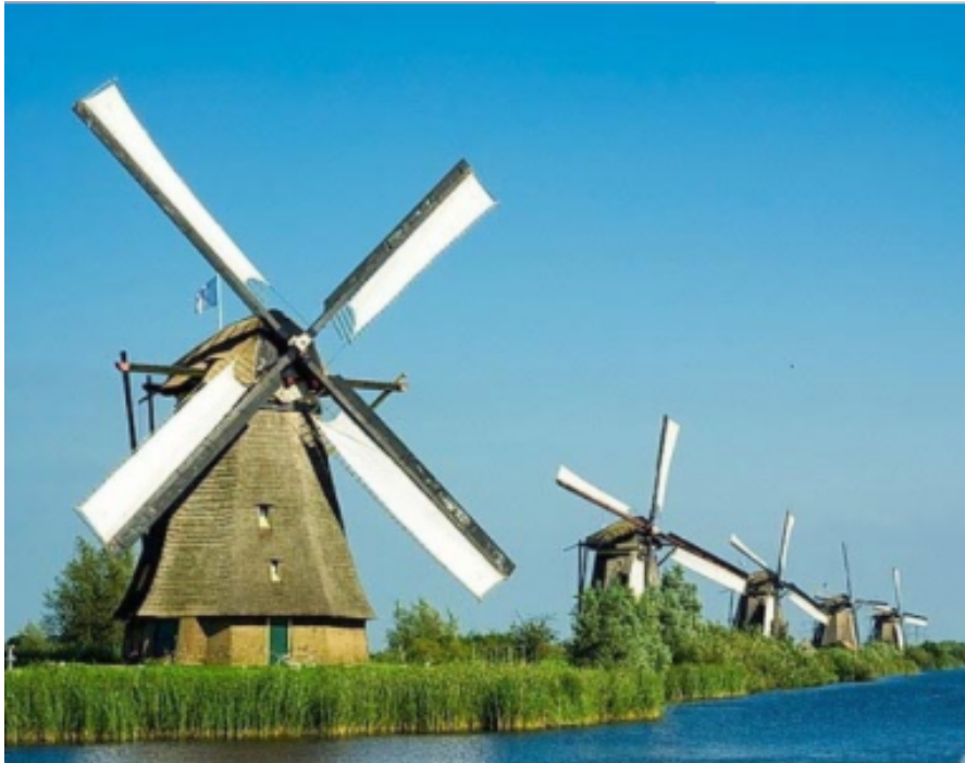
早成功应用的水平轴风力机——荷兰风车
