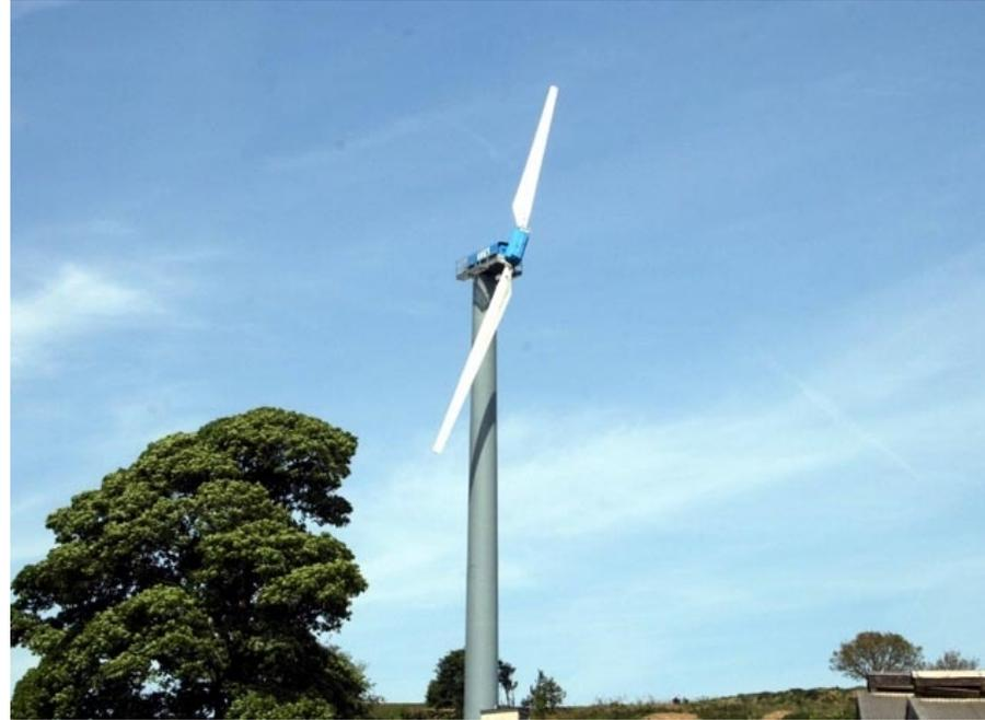
2叶片水平轴风力发电机
