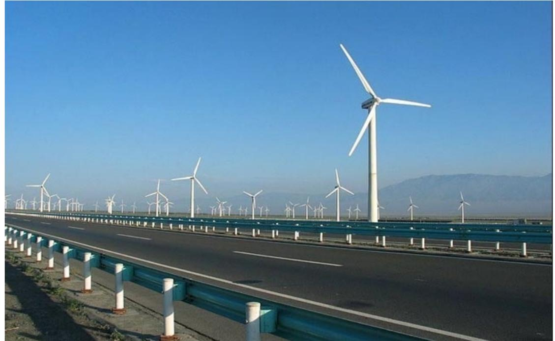
陆地水平轴风力发电机
